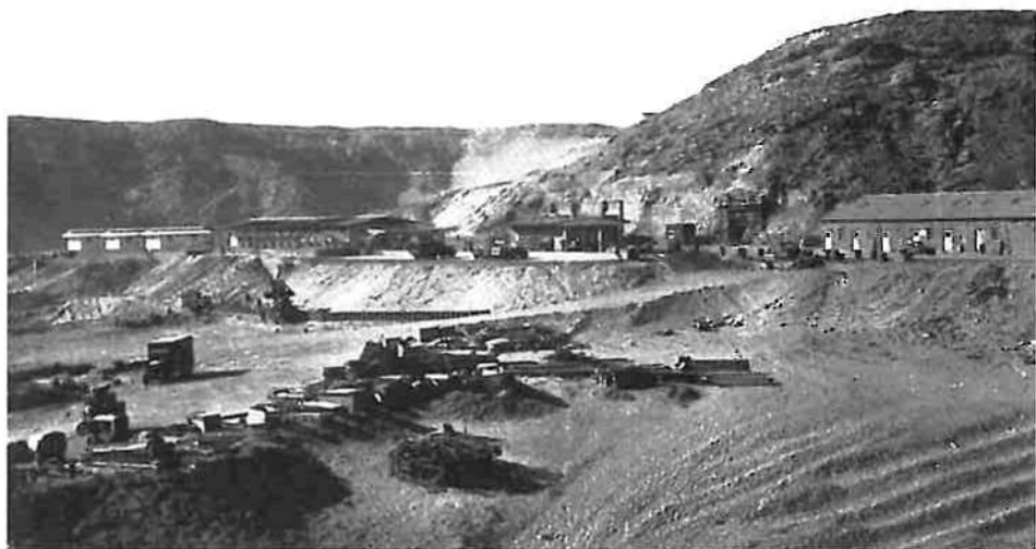
Reggan : vue des installations techniques.
